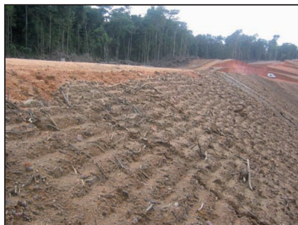
Finition avec compacteurs
