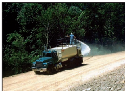
Application du procédé EUROCOVER DC sur pistes et sur stockage de matériaux
