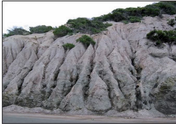
Exemple d'érosion pluviale.
