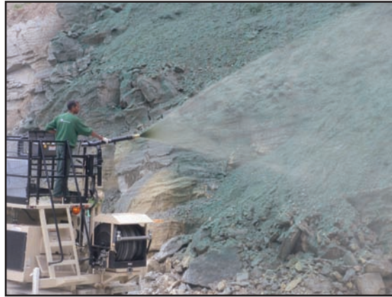
Application au canon avec buse "intermédiaire"
