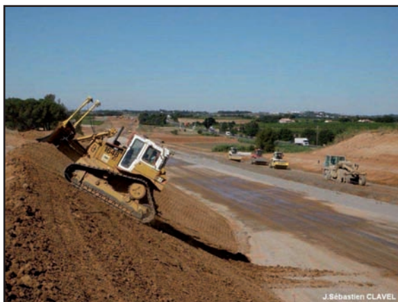
Finitions avec engins à chenilles ou avec pelles à godet
