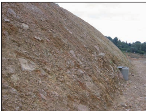
Talus de déblai
