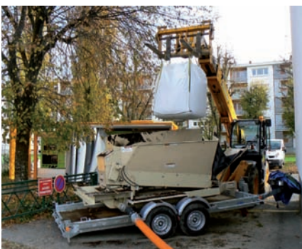
Mise en oeuvre d'un substrat toiture avec EURO BLOWER 302 HD
