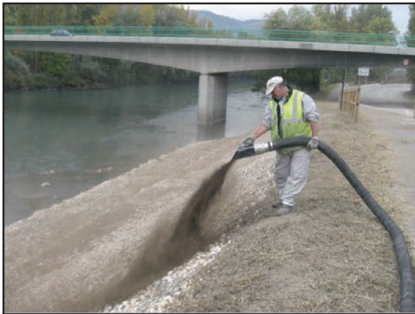
Traitement type Terraseeding avec Bark Blower modèle 1216 équipé d'un système d'injection de semences
