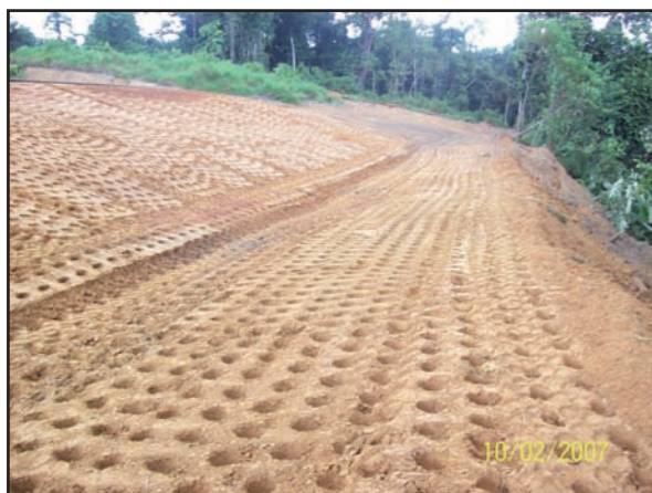
Finition avec compacteurs
