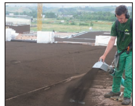
Mise en oeuvre d'un substrat toiture avec EURO BLOWER 302 HD
