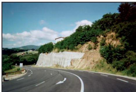
Traitement d'un talus bétonné avec le procédé de vieillissement NATUROC
