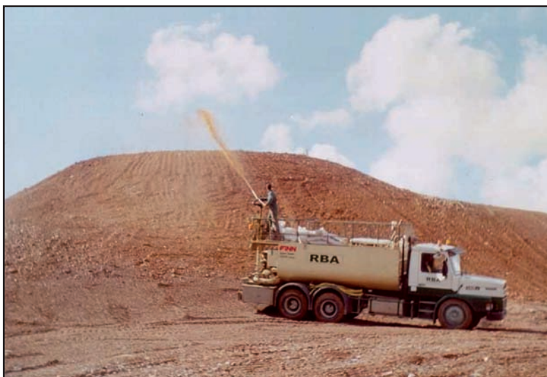
Ensemencement par hydroseeding
