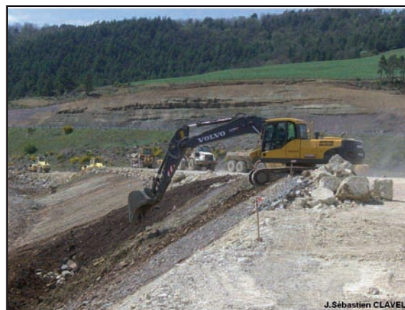
Finitions avec engins à chenilles ou avec pelles à godet
