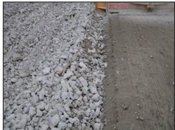
Préparation de sol par concassage
