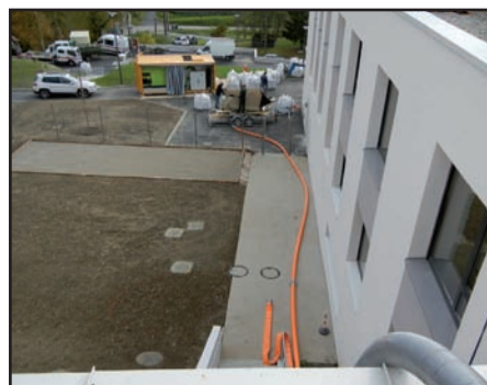
Mise en oeuvre d'un substrat toiture avec EURO BLOWER 302 HD
