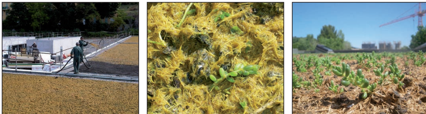
Semis par hydrosprigging du procédé VERTOIT et levée des boutures 2 semaines après
