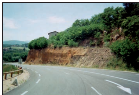
Traitement d'un talus bétonné avec le procédé de vieillissement NATUROC
