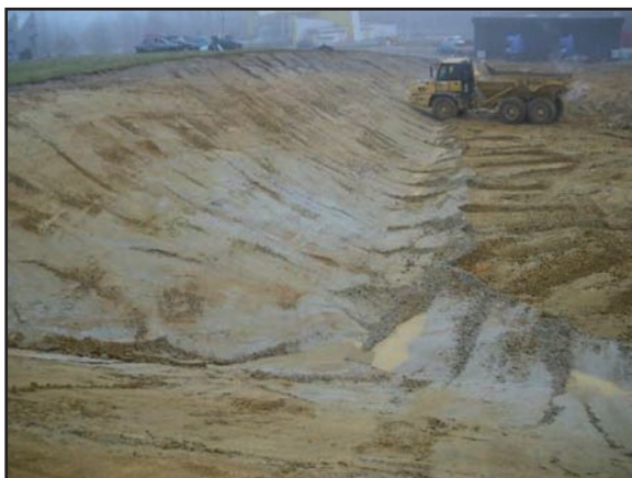
Exemples de nivellement rendant des substrats difficilement végétalisables
