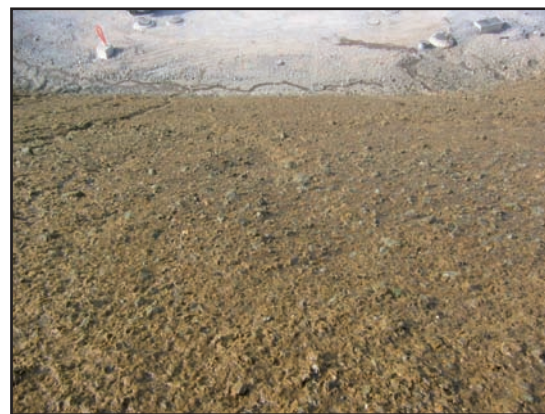
Dosage de mulch 150 bottest/ha X 1.2 = 180 bt/ha (à gauche) Dosage de mulch 150 bt/ha (à droite)
