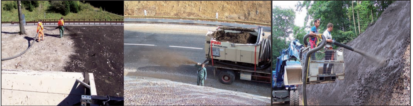
Application de substrat organique avec matériel Bark Blower modèle 605
