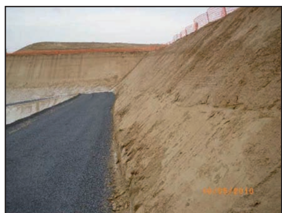
Exemples de nivellement rendant des substrats difficilement végétalisables
