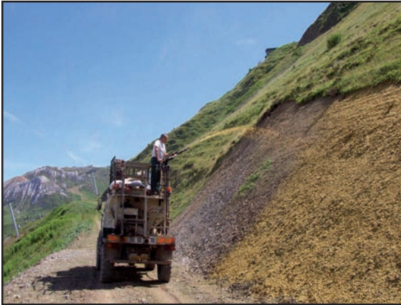
Application de l'hydromulching au canon
