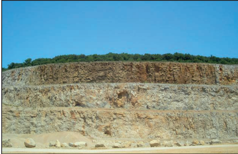
Zone rocheuse partiellement traitée avec le procédé de vieillissement NATUROC
