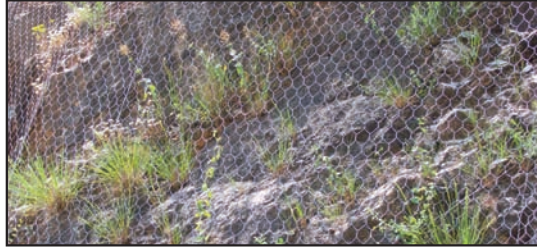
Zone rocheuse traitée par le procédé de vieillissement NATUROC avec semis d'espèces saxicoles
